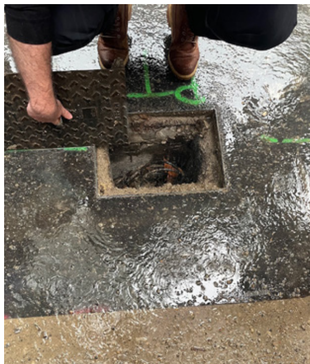
Figure 1. Visite guidée avec l'enseignant qui soulève la plaque d'une chambre de tirage avec une marque de génie civil inscrit sur le trottoir. Crédit : Merel van Zanen.
